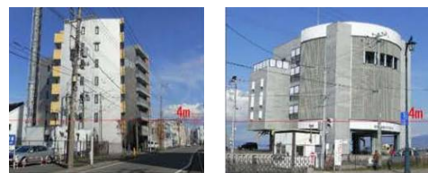
写真-4 仮一時避難可能なビルの例
