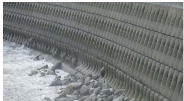
写真-1 直積ブロックの摩耗被害
