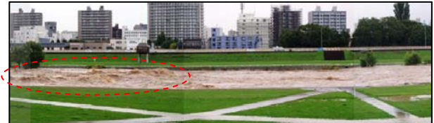
図-7 豊平川5号床止（平成23年9月出水） ：三角波
