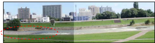
図-8 豊平川5号床止（出水後の土砂堆積） ：土砂
