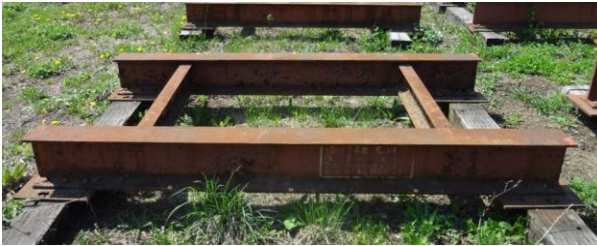
図-1 岩尾川橋梁
