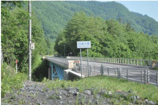
写真-1 橋梁全景
