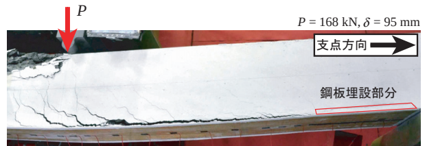
写真－3 終局時近傍におけるひび割れ性状
