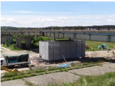
図-10 橋脚の補修状況 (志田橋)
