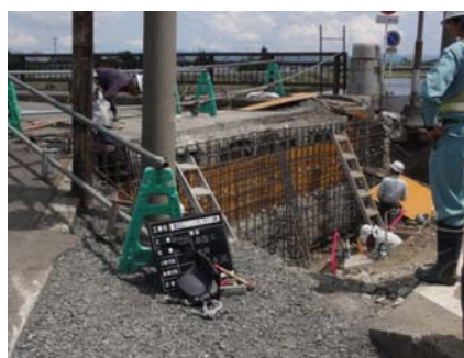
図-5 橋台パラペットの打替え（錦橋）
