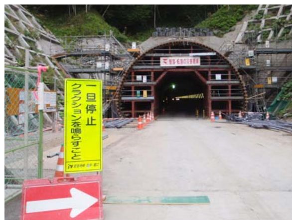
写真-2 圧電素子マット設置状況
