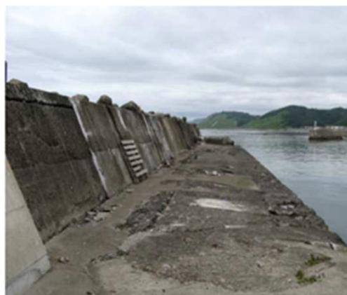
図-2 防波堤の外観
