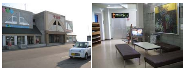
写真-1 一般的にみられる屋外や屋内に快適な休憩空間が提供されていない道の駅の事例
