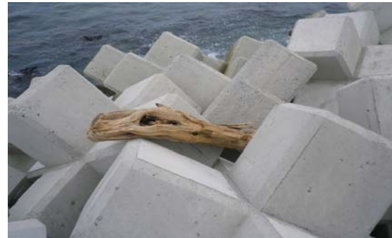
写真-1 消波ブロック上の流木
