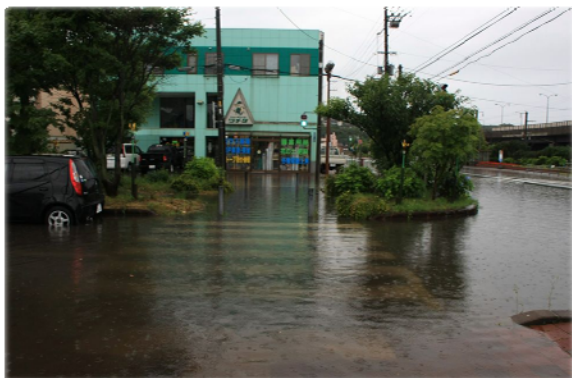
写真-1 冠水時の最大被害箇所の様子 (上:通常時,下:2010 年 8 月 12 日冠水時 4) )
