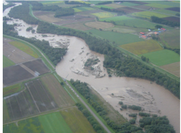
図-1 堤防流出箇所 (平成23年9月7日午前, KP18.2 付近)
