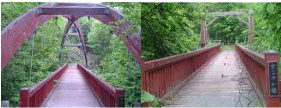
写真-1 やすらか橋 (ニールセン橋) 写真-2 すこやか橋 (斜張橋)
