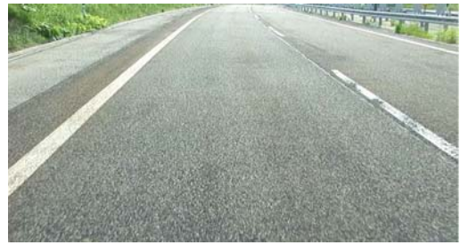
写真-3 断熱材工法 (t=5 cm) 上り線
