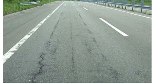
写真-4 断熱材工法 (t=10 cm) 上り線
