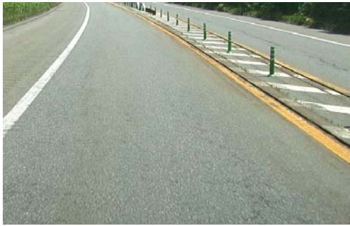
写真-6 断熱材工法 (t=5 cm) 下り線
