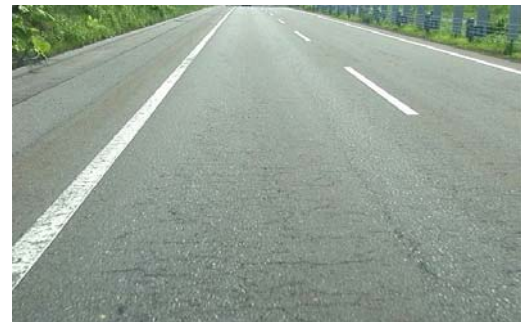
写真-5 置換工法 (t=100 cm置換) 上り線
