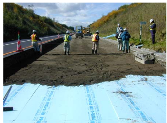
写真-2 断熱材の敷設状況
