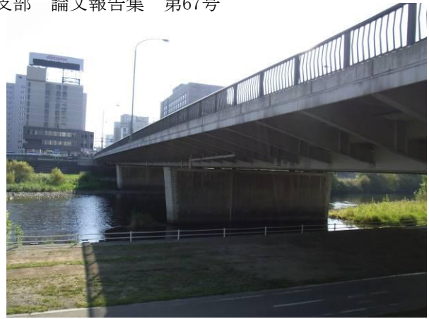
写真-6 現在の豊平橋
