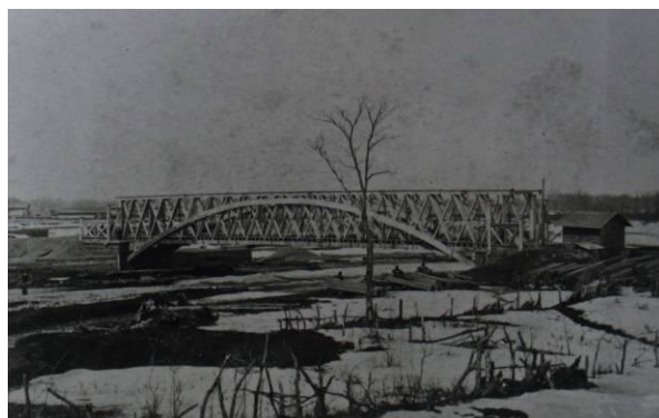
写真－3 ホイラーの豊平橋（北大図書館所蔵）
