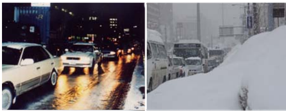
写真-1 冬期道路の状況 (左：凍結路面 右：路肩堆雪)
