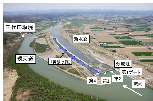
図-1 十勝川千代田新水路概況 (2007年7月、帯広開発建設部撮影)
