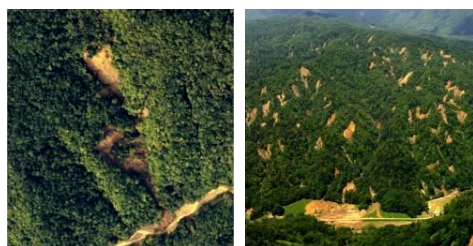
写真-1 2003 年の豪雨による崩壊地 1)
