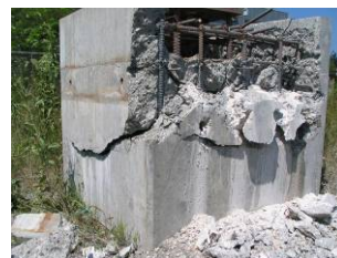
写真 4.4 予備破砕状況 1
