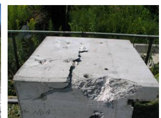
写真 4.5 予備破砕状況 2
