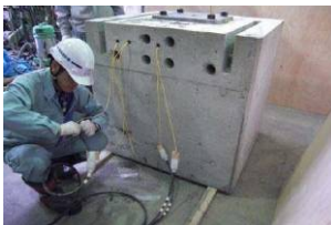
写真 3.3 支承交換破砕前
