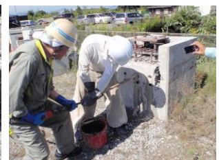
写真 4.3 静破砕剤の施工
