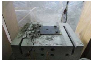
写真 3.4 支承破砕状況 1
