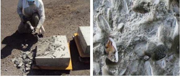
写真2 電動ピック工法とそのはつり面
