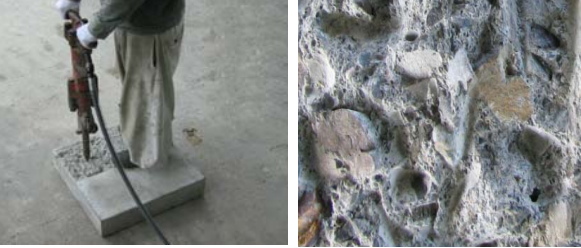
写真3 コンクリートブレーカー工法とそのはつり面
