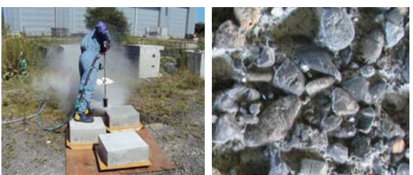
写真1 ウォータージェット工法とそのはつり面
