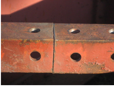
図 6 切断による損傷
