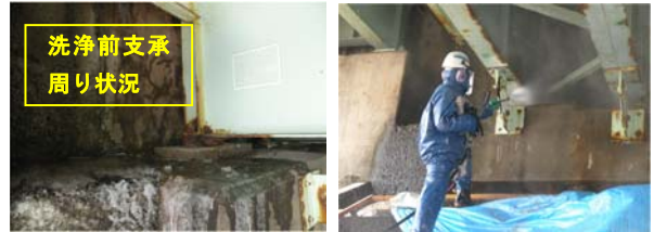
写真-5 桁端部支承周り洗浄状況
