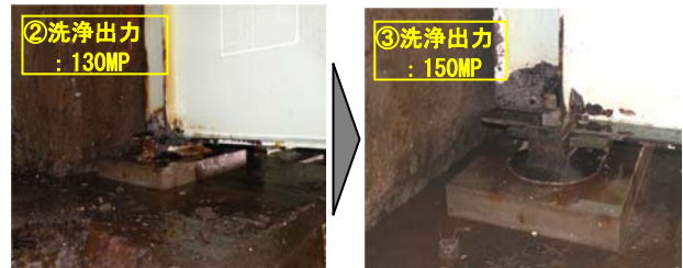
写真-6 水圧別洗浄（錆落し）状況
