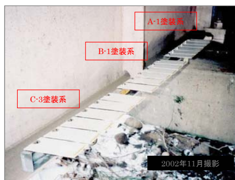
写真-1 暴露供試体の設置状況
