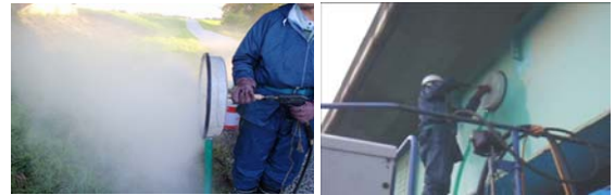
写真-2 チューブノズルによる洗浄状況
