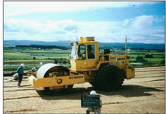
写真-1 転圧力320kN級振動ローラによる転圧
