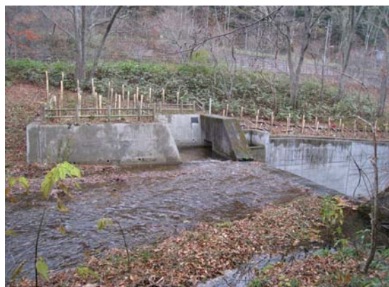
写真-2 魚道上流部の状況（擁壁が水制工として機能し土砂堆積が抑制されている様子）
