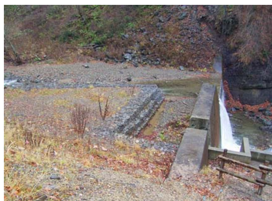
写真-1 魚道上流部の状況（護岸工を設置するも土砂が堆積している様子）
