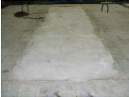
写真3 補強供試体-上面側断面修復状況
