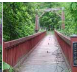
写真 - 2 すこやか橋 (斜張橋)
