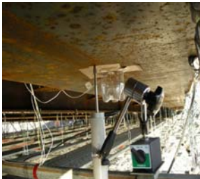
写真-1 変位計の設置
