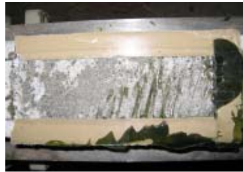
(コンクリート側)
