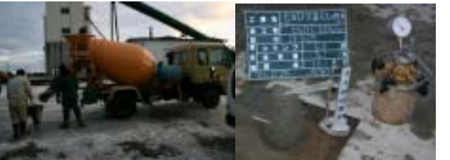
写真2 プラントによる混練り試験状況
