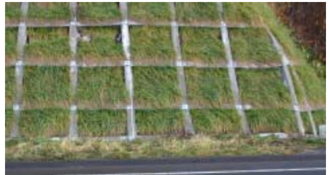
写真5 施工一年後のフリーフレーム施工状況(下段右から4枠)
