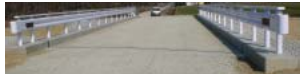
写真6 道路橋の床版と地覆の施工例(冬期3月施工,床版コンクリート:スランブ8cm、空気量5%、コンクリート温度11℃)
