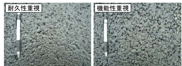
写真-8 仕上がり状況
