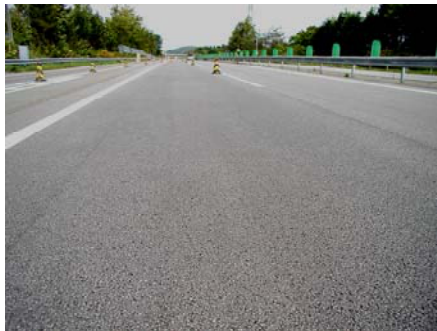
写真-9 施工後2年経過した北海道型
