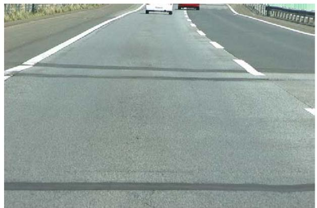
写真-1 著大な振動の起因となる高速道路上の段差例
