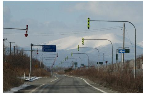
写真-9 固定式視線誘導柱によりスカイラインが分断され眺望を阻害
