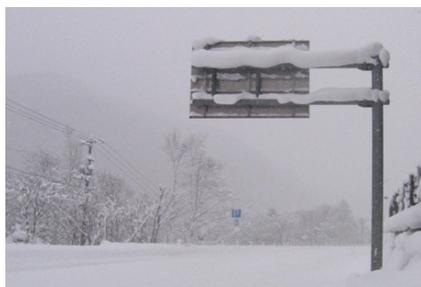
写真-4 片持式標識への着雪状況事例
