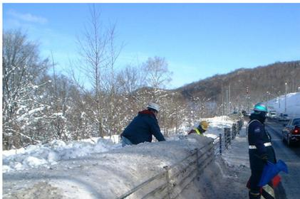
写真-5 防護柵背面の人力除雪
