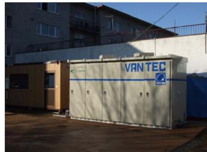
写真 - 2 燃料電池システム
