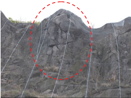
写真-1 実岩盤斜面
