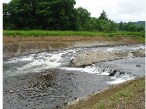
写真-1 河道の基岩露出部
