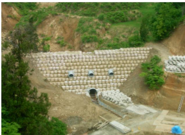
写真-1 仮締切り(土囊)築堤
