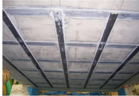
写真-3 CFRPプレートによる補強
