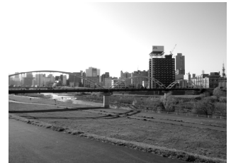
豊平川第一水管橋
