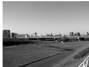
南十九条大橋
