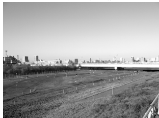
南二十二条大橋
