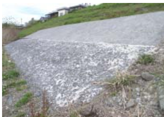
写真-1 現場打ち練石張り工法
