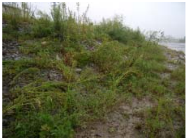
写真-4 施工後約 1 年半（平成 19 年 9 月）
