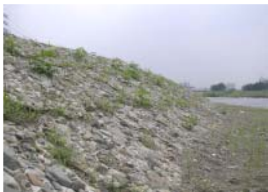
写真-2 プレキャスト石張り護岸工
