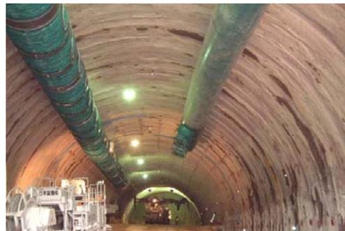
写真-2 風管設置状況
