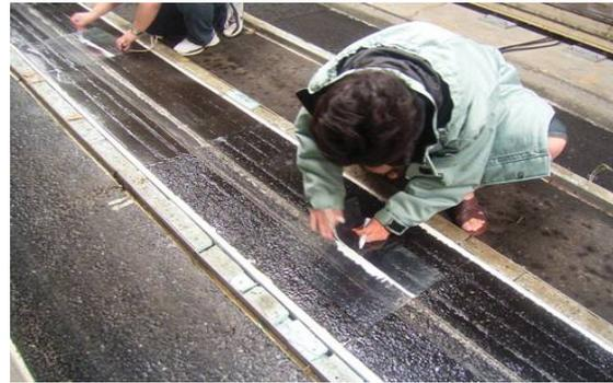
写真-8 ラミネートシートを使用した作業
