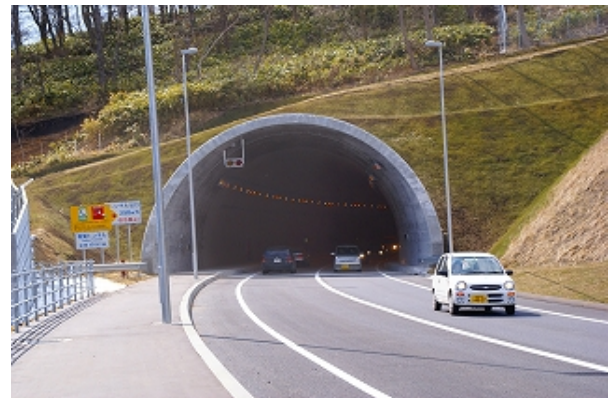
写真－3 開通直後の一般国道 230 号新ルート (青葉トンネル)
