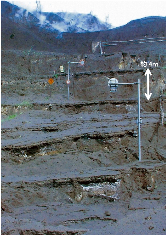
写真－2 地殻変動により地溝が発生した 一般国道 230 号 4)
