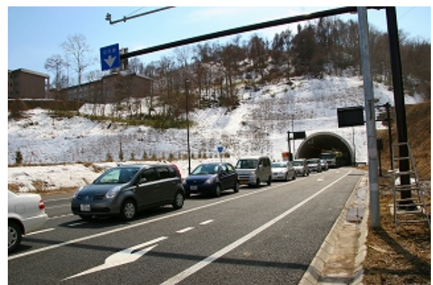
写真－4 開通直後の一般国道 230 号新ルート (三豊トンネル)
