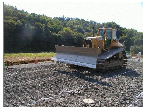
写真2 ブルドーザによる破碎走行
