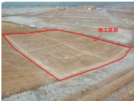
写真-3 カバーロック掘削後の状況
