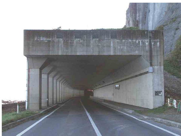
写真-1 落石防護覆道の一例
