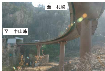
写真-1 無意根大橋全景（P3-P6径間）
