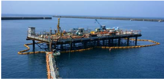
写真-3 地盤改良施工状況
