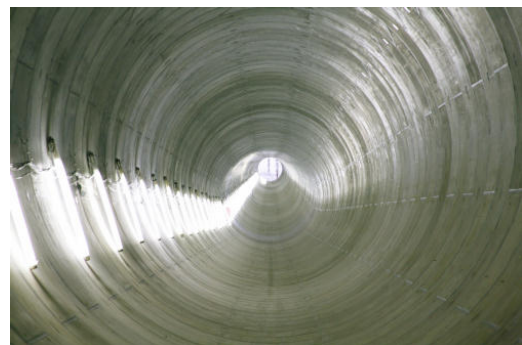
写真-7 トンネル坑内全景
