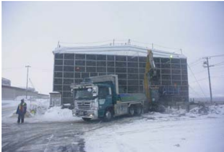
写真-4 冬季の作業状況
