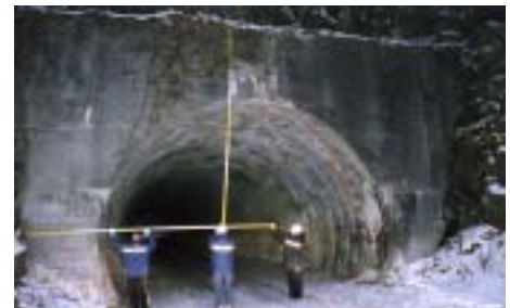
Photo.3 不二川トンネル, 延長76.8m
