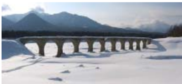
Photo.1 タウシュベツ川橋梁(コンクリートアーチ, 橋長130m, 11径間)
