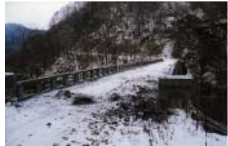
Photo.2 不二川橋梁, PC ラーメン, 橋長74.5m
