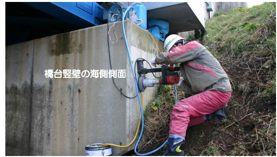
写真-2 コアボーリング状況の一例
