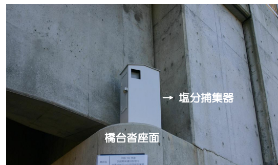
写真－1 塩分捕集器の設置状況の一例
